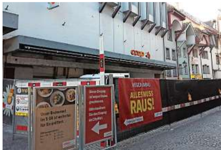
Baustelle Igelweid: Der Coop City im Aarauer City-Märt wird umgebaut
